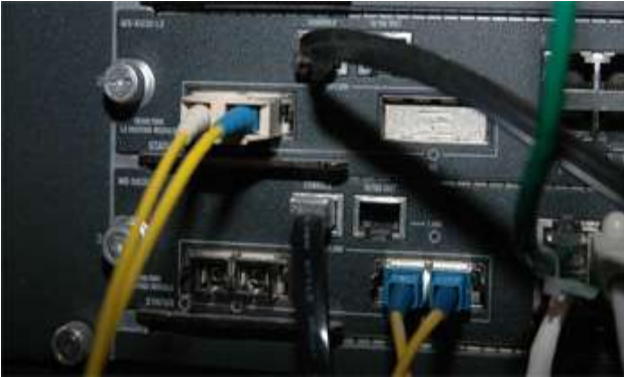
Fig. 4 : Arrivée du réseau fédérateur en fibre optique (jaune)
