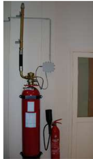
Fig. 10 : Système d'extinction FE13
